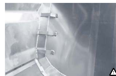
11 Vzpon v korito (notranji) Na notranji čelni steni segmentnega korita je privarjenih več stabilnih stopnih površin. To omogoča nemoten in varen vstop ter izstop.
