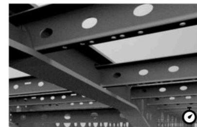
0 Okvir v lahki gradnji Izračuni po metodi končnih elementov in praktični preizkusi potrjujejo stabilnost.
